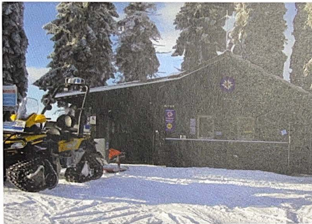
Rettungsstützpunkt im Gipfelbereich
